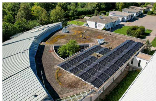
Der Kindergarten Ziegelbach in Villingen aus der Vogelperspektive. Eine PV-Anlage liefert Strom für den Kindergarten.
